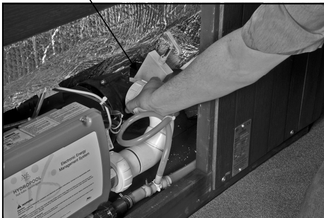
...DURCH DEN PUMPEN-ANSCHLUSS LÖSEN EINER LUFTSCHLEUSE...
