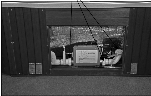
...DURCH DEN PUMPEN-ANSCHLUSS LÖSEN EINER LUFTSCHLEUSE...
